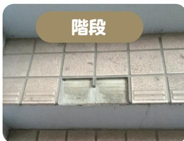
タイルが欠けています。入居者のケガなどにつながりますので、一部補修・全体の補修の見積りを取り、キレイにします。
